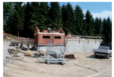
Betriebsgebäude in Bau
