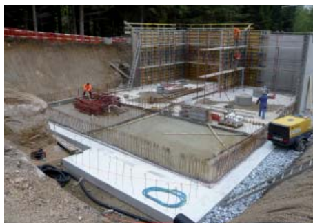
Bodenplatte und Wände Belebungsbecken
