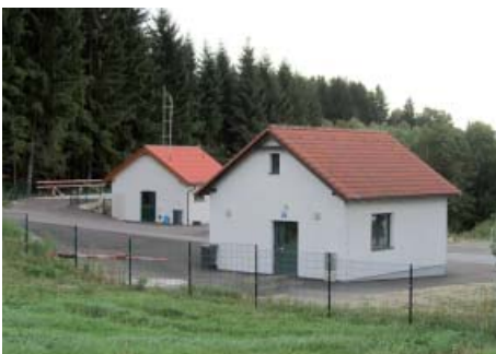
Rechenhaus und Betriebsgebäude
