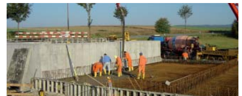
Bodenplatte für Vererdungsbecken
