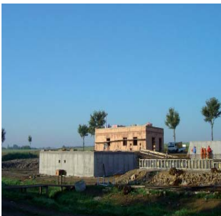
Bau Kläranlage Kautzen
