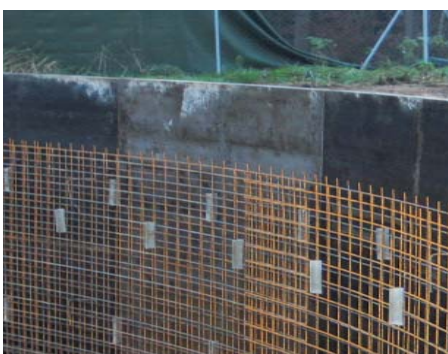
Bewehrungsabnahme Wände Speicherbecken
