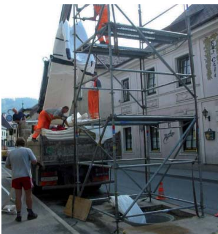
Re-Liner einziehen
