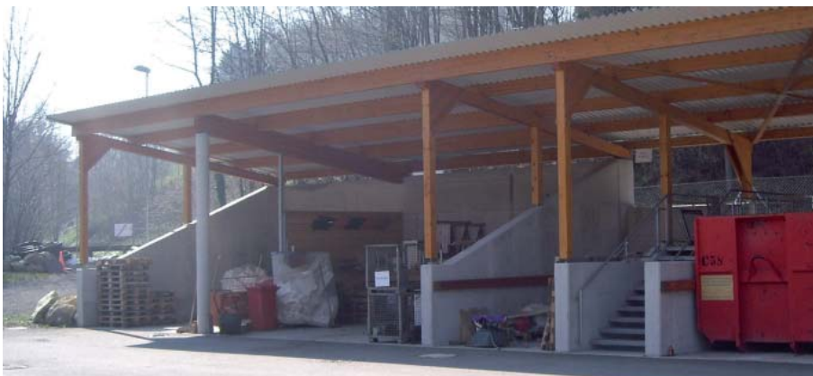
Mülltrennung überdacht - zur Vermeidung von Kontaminierung des Regenwasserkanals
