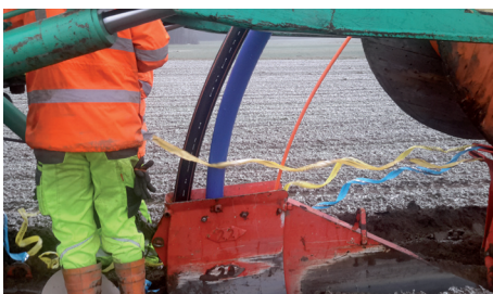
Detail Pflugverlegung
