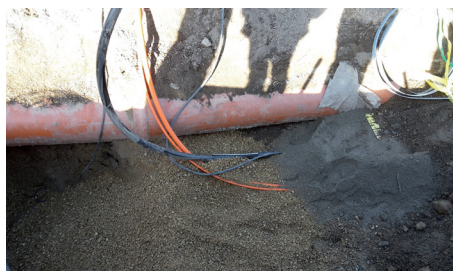
Mitverlegung LWL-Leerrohre
