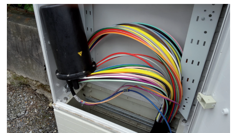
Verteilerkasten
