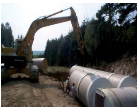
Fertigteil Tiefbehälter aus GFUP Rohren
