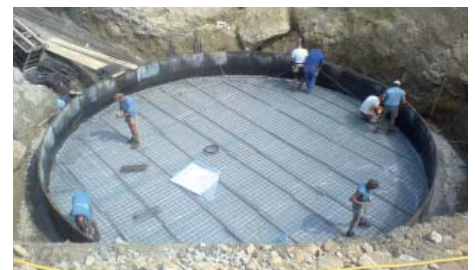
Bewehrung Bodenplatte Belebungsbecken
