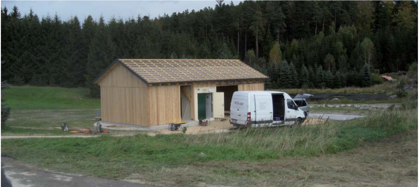
Neubau Kläranlage Rindlberg
