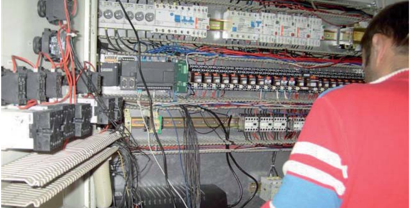
Umbau Steuerung auf SPS-Steuerung
