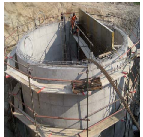
Betonieren des Belebungsbeckens
