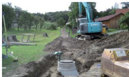
Errichtung des Schmutzwasserkanals
