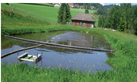
Kläranlage VOR Umbau Teichkläranlage
