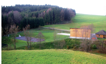
Kläranlage NACH Umbau Teichkläranlage
