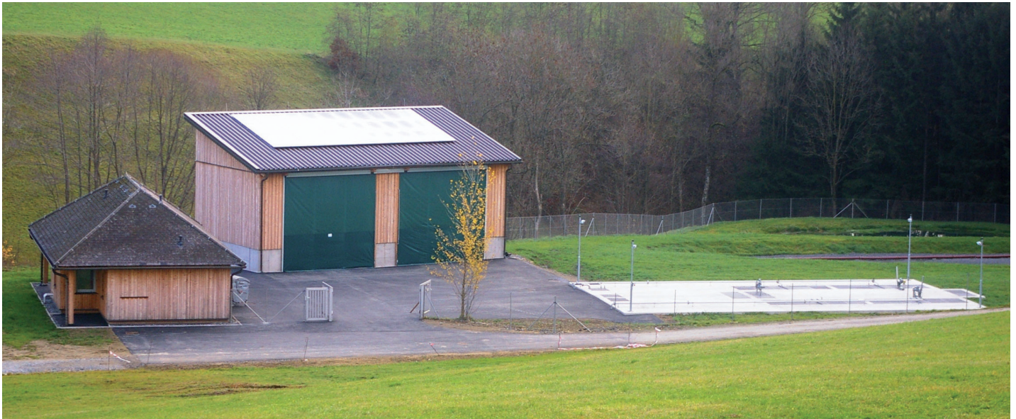
Kläranlage St. Oswald
