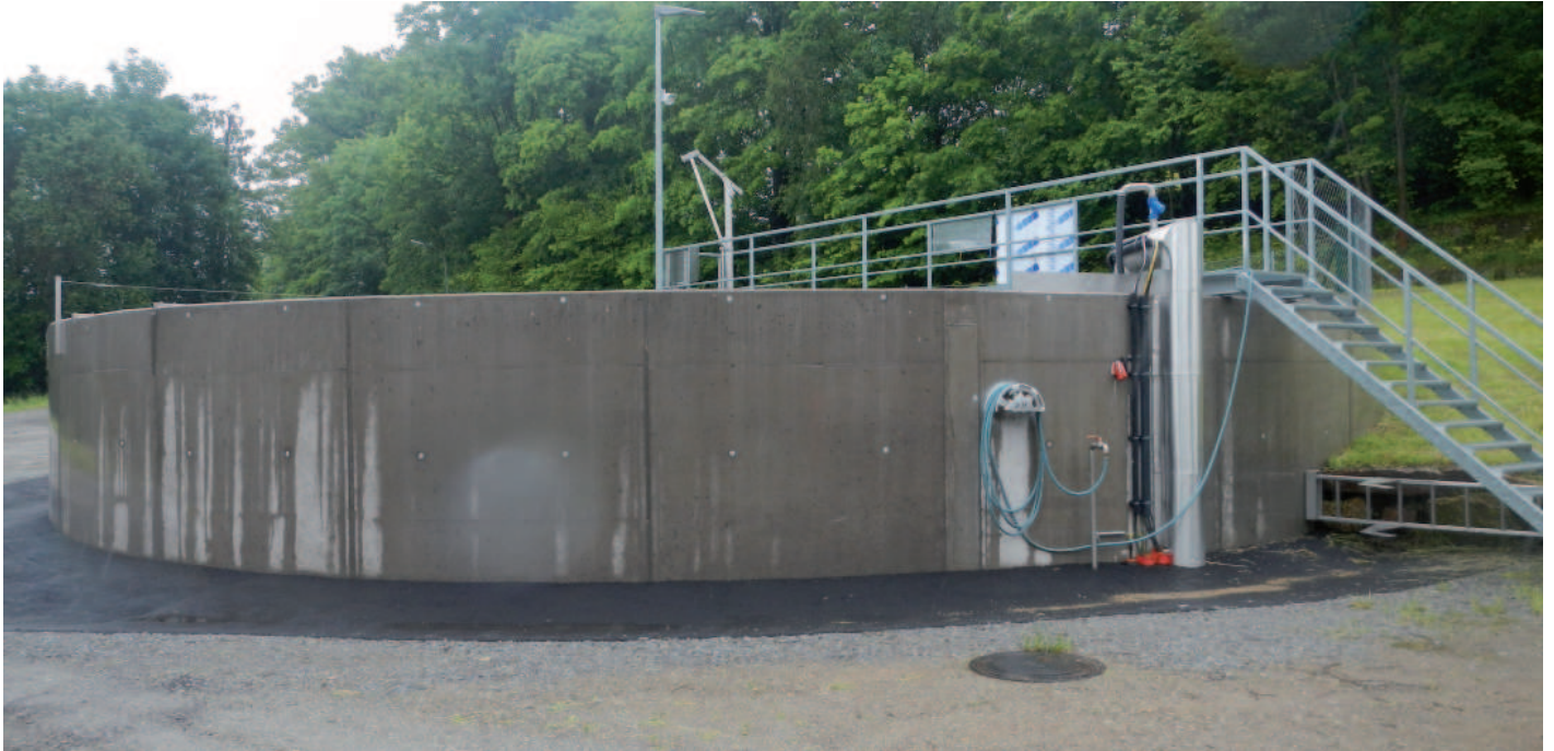
Regenüberlaufbecken der Stadtgemeinde Weitra
