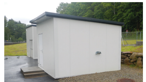
Betriebsgebäude für Mechanische Vorreinigung
