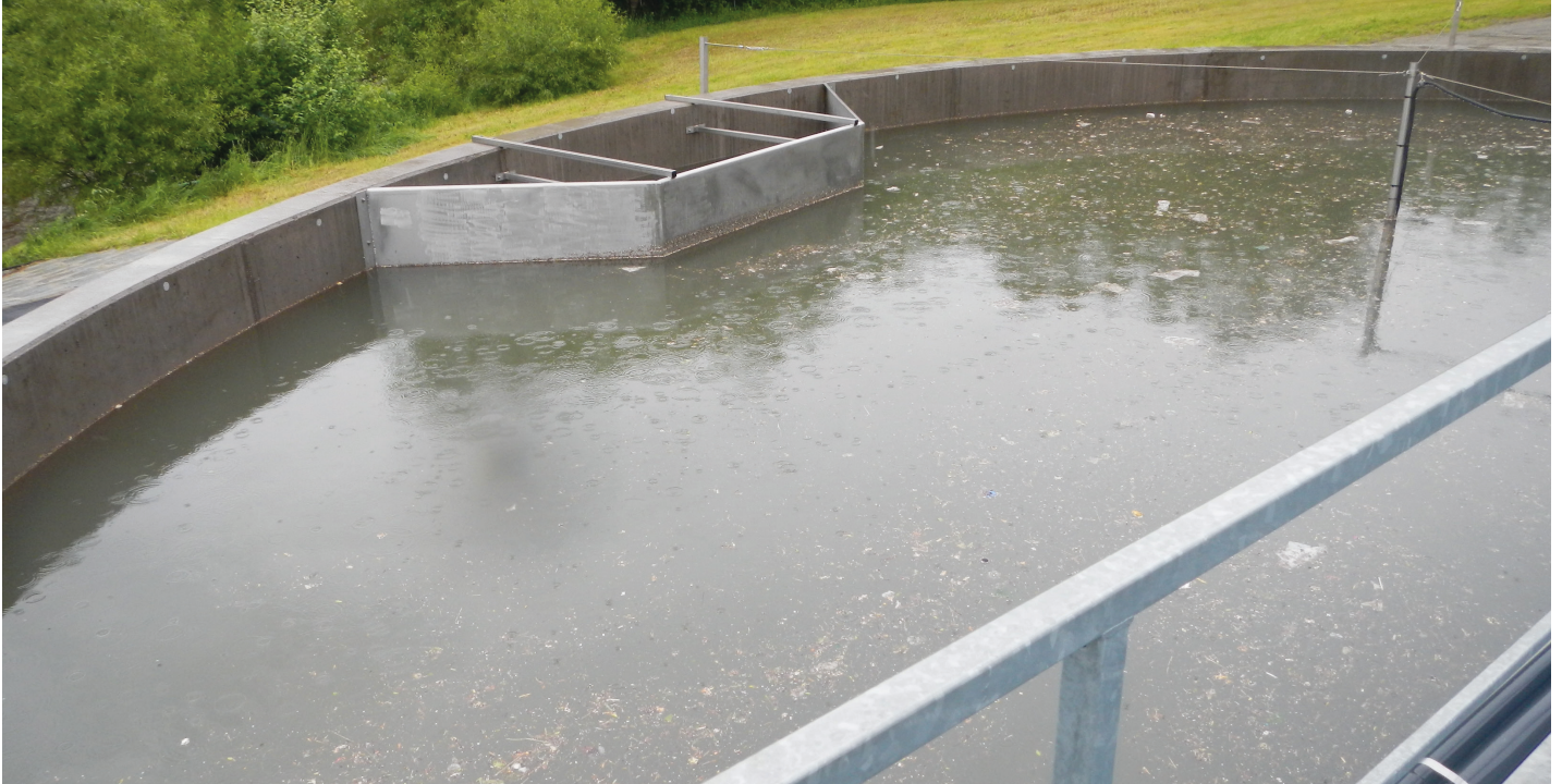
Regenüberlaufbecken bei Vollfüllung
