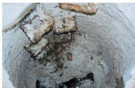
Durch Schwefelwasserstoff korrodierter Schacht
